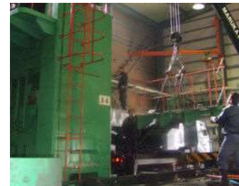
移設、整備、改造
